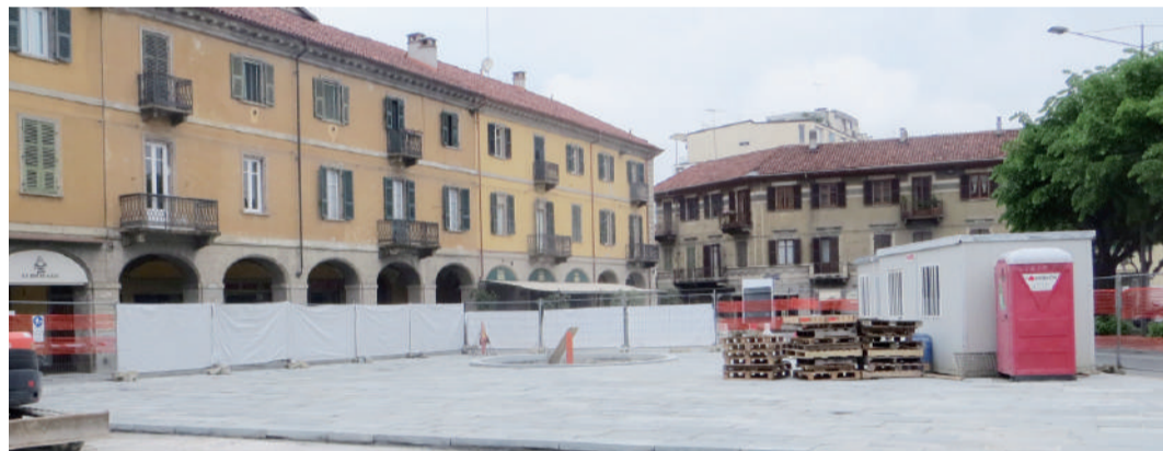
Sull'area già coperta con la pietra, lo spazio dove verrà inserita la fontana ora al centro di Piazza Garibaldi.
